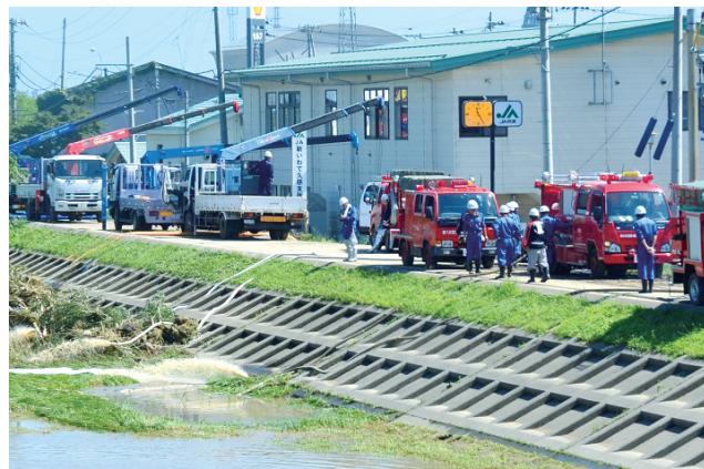
排水作業（久慈市消防団提供）
