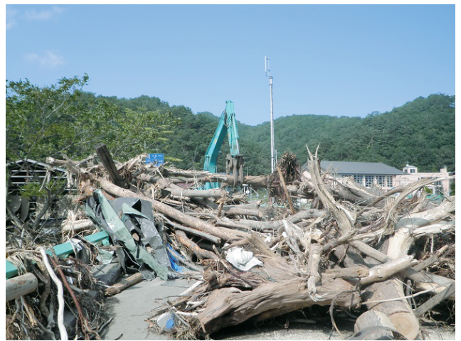
被災後の状況 （岩泉町安家地区 仙台市消防局提供）
