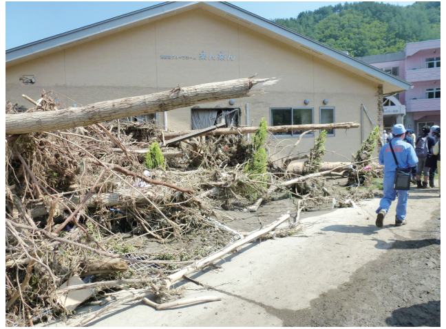
グループホーム周辺に堆積した流木（岩泉町乙茂地区）
